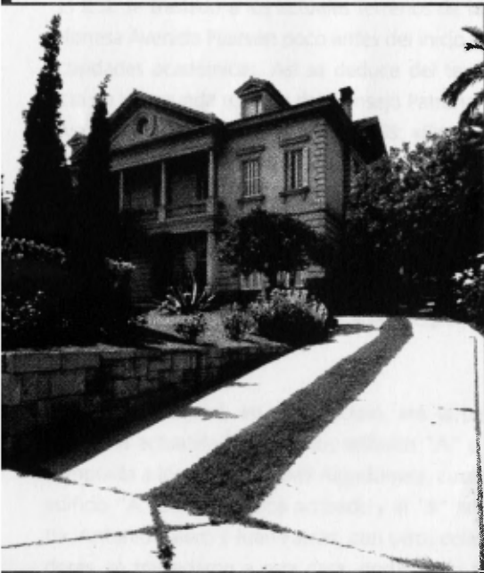
Edificio A en noviembre de 1958
