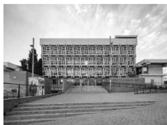
Fig. 6. Entrada principal de la facultad. Autoría de Filippo Poli. Arquitecturacatalana.cat , COAC, Barcelona.
