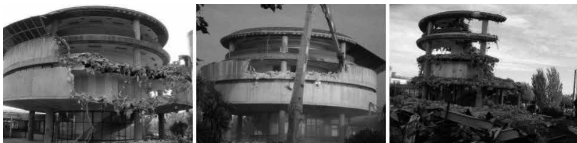
Fig. 8. Demolición de la biblioteca de Filosofía (noviembre de 2006) para construir el Parc Científic.
