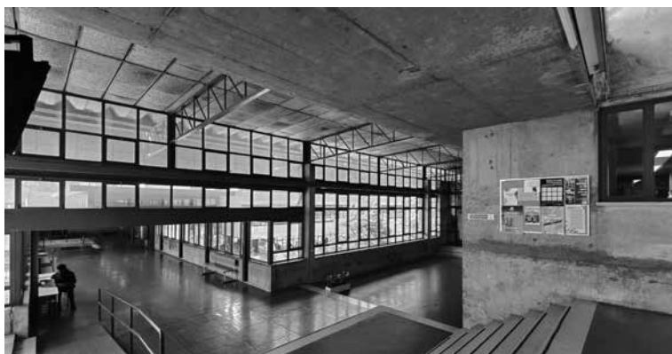
Fig. 4. Vista interior de espacios de conexión entre fases III y IV. Fotografía Jorge Ramos.
