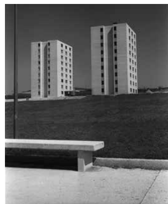
Fig. 25. Torres del Colegio Mayor Belagua, Pamplona, 1968. I. Araujo, J. Lahuerta.
