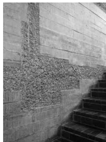
Fig. 7. Detalle de los trabajos sobre el hormigón en el arranque de la escalera. Fuente: Docomomo.
