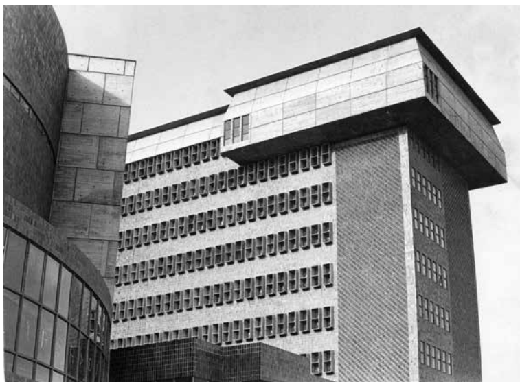
Fig. 3. Detalle de las fachadas que muestra los materiales, su modulación y combinación de texturas. Fuente: Docomomo.
