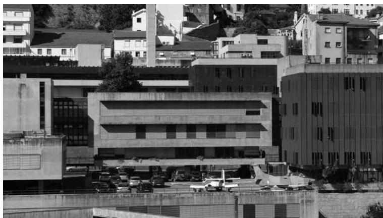
Fig. 5. Vista exterior de los edificios de la Fase IV y V. Fotografía Jorge Ramos.
