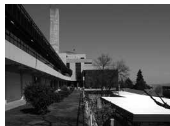
Fig. 3. Vista exterior de las plataformas y edificios de la Fase III. Fotografía Jorge Ramos.
