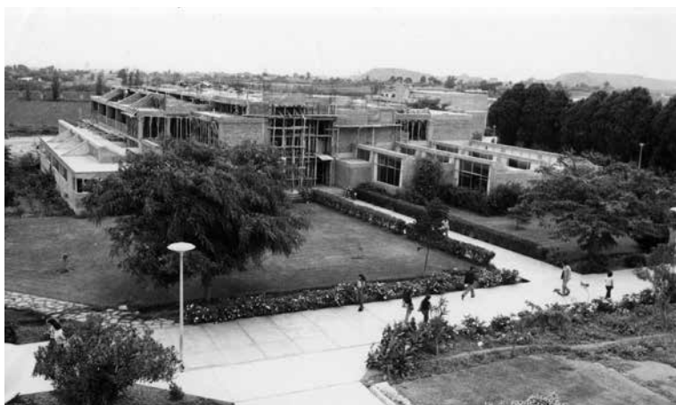
Fig. 5. Fotografía de la Biblioteca Central de la PUCP, durante la construcción (1971). Se distingue el andamiaje en el lugar reservado para la mampara de ingreso. En la cara sur se observan las teatinas ya construidas y las vigas de concreto exteriores. En el fondo se distinguen los restos arqueológicos de dos "huacas" del conjunto de Maranga. Fuente: Archivo de la Universidad PUCP, Archivo Audiovisual.
