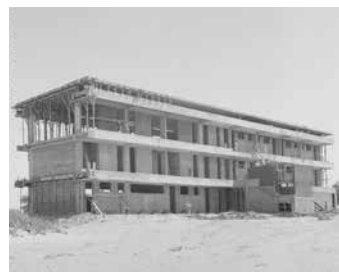
Fig. 1 Fotos de la construcción de la primera etapa del Edificio Principal de la Universidad de Piura. 1968-1969.
