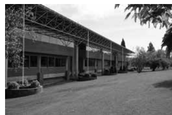
Fig. 22. Escuela de Arquitectura, Pamplona, 1978. E. Aguinaga, C. Sobrini, R. Echaide.
