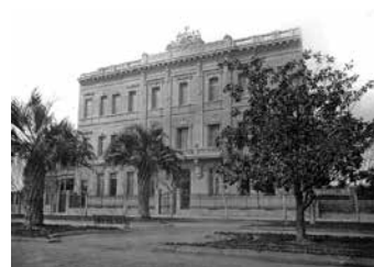
Fig. 1. Frente del edificio sobre Boulevard Oroño. Fuente: Centro de Documentación e Investigación de la Arquitectura Pública.
