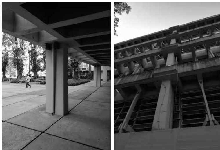
Fig. 3. Detalles de la estructura en planta baja y de las fachadas. Fuente: Luz Paz Agras, 2019.
