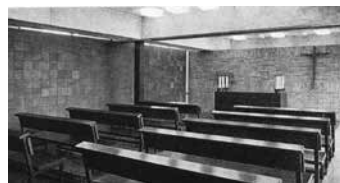
Fig. 7. Sala de la capilla de la facultad. Fondo Quaderns d'Arquitectura i Urbanisme nº 68-69, 1967, pp. 32-72. AH-COAC, Barcelona.
