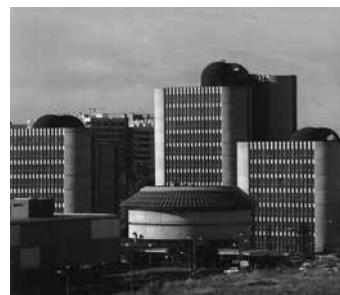
Fig. 1. Vista general de la Facultad de Filosofía y Letras. En primer término, el edificio del Decanato; en el centro, la biblioteca de Filosofía; y, al fondo, tres de las cuatro torres.
