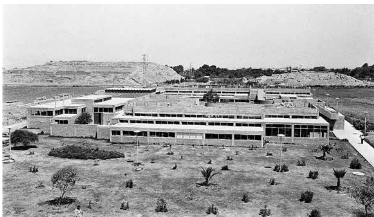
Fig. 2. Fotografía panorámica de los edificios aterrazados del Laboratorio de Ingeniería Mecánica y el Laboratorio de Ingeniería de Minas, ambos con la estructura preparada para una futura ampliación. En el fondo se ven los restos arqueológicos Huaca Tres Palos y Huaca Cruz Blanca, pirámides aterrazadas construidas con ladrillos de tierra. Fuente: Fondo Documental COOPER GRAÑA NICOLINI, Archivo de Arquitectura PUCP.
