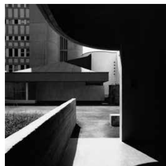
Fig 3. Exterior view of the entrance area, ©Gabriele Basilico, Fondazione Archivio Vico Magistretti.
