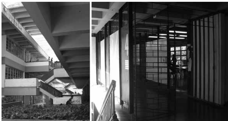
Fig. 5. Espacios intermedios entre plataformas y en plataformas de edificios. Fuente: Luz Paz Agras, 2019.
