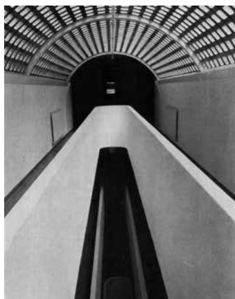
Fig. 4. Fotografía del pasillo de la última planta con la bóveda de pavés sobre los lucernarios lineales de los pasillos en la primera fase de la ETSAVa (1975). (Fuente: Arquitectura n° 223, 1980, p. 23).
