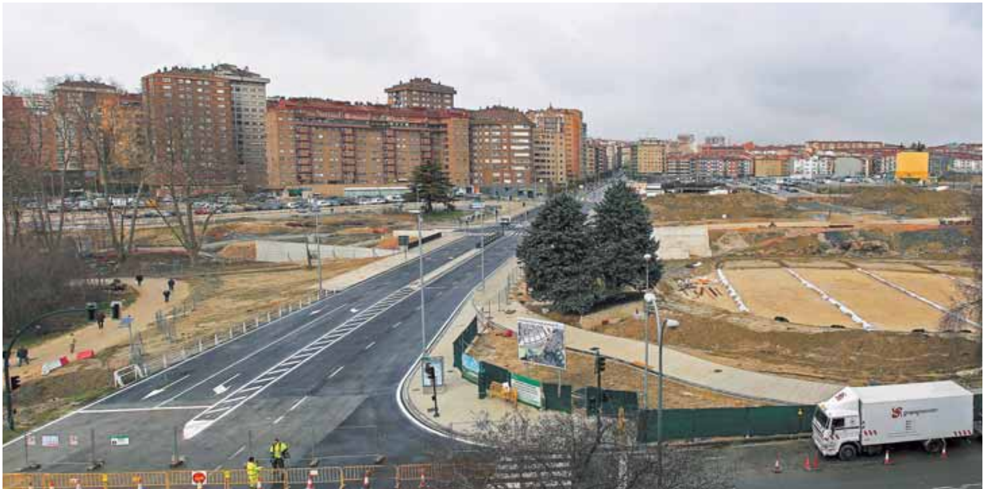
Últimos retoques, ayer, en el nuevo puente sobre el río Sadar, cuya construcción ha sido la causa del cierre.
