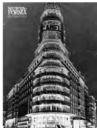
Fig. 5. Edificio Capitol: "expresionismo y comunicación".
