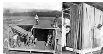
Fig. 3. Fases del montaje de una vivienda. Sistemas de prefabricación en EEUU, RNA n. 42, 1945.
