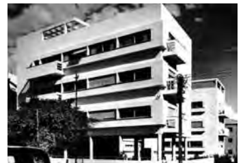
Fig. 9. Casa Engel, en Bulevar Rothschild, de Ze'ev Rechter, 1934, primer edificio sobre pilotis en Tel Aviv.
