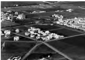
Casa Duclós en construcción. Fototeca del Archivo Municipal de Sevilla. Año incierto.
