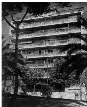
Fig. 6. Edificio de vivienda colectiva en Barcelona diseñado en 1940, obra de Mitjans.
