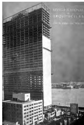
Fig. 3. RNA, n. 109, enero 1951. El Edificio de Naciones Unidas en Nueva York.
