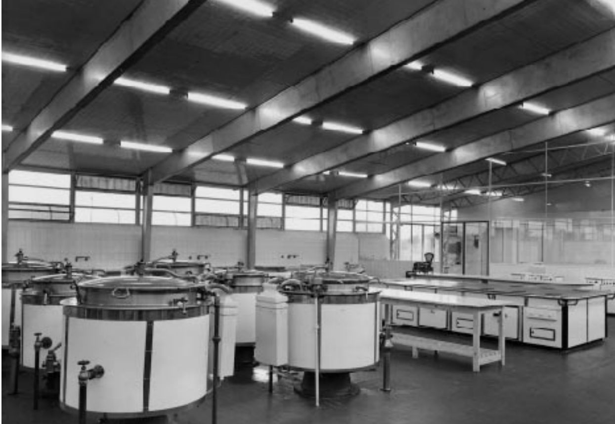
Cocinas de los comedores i 19
