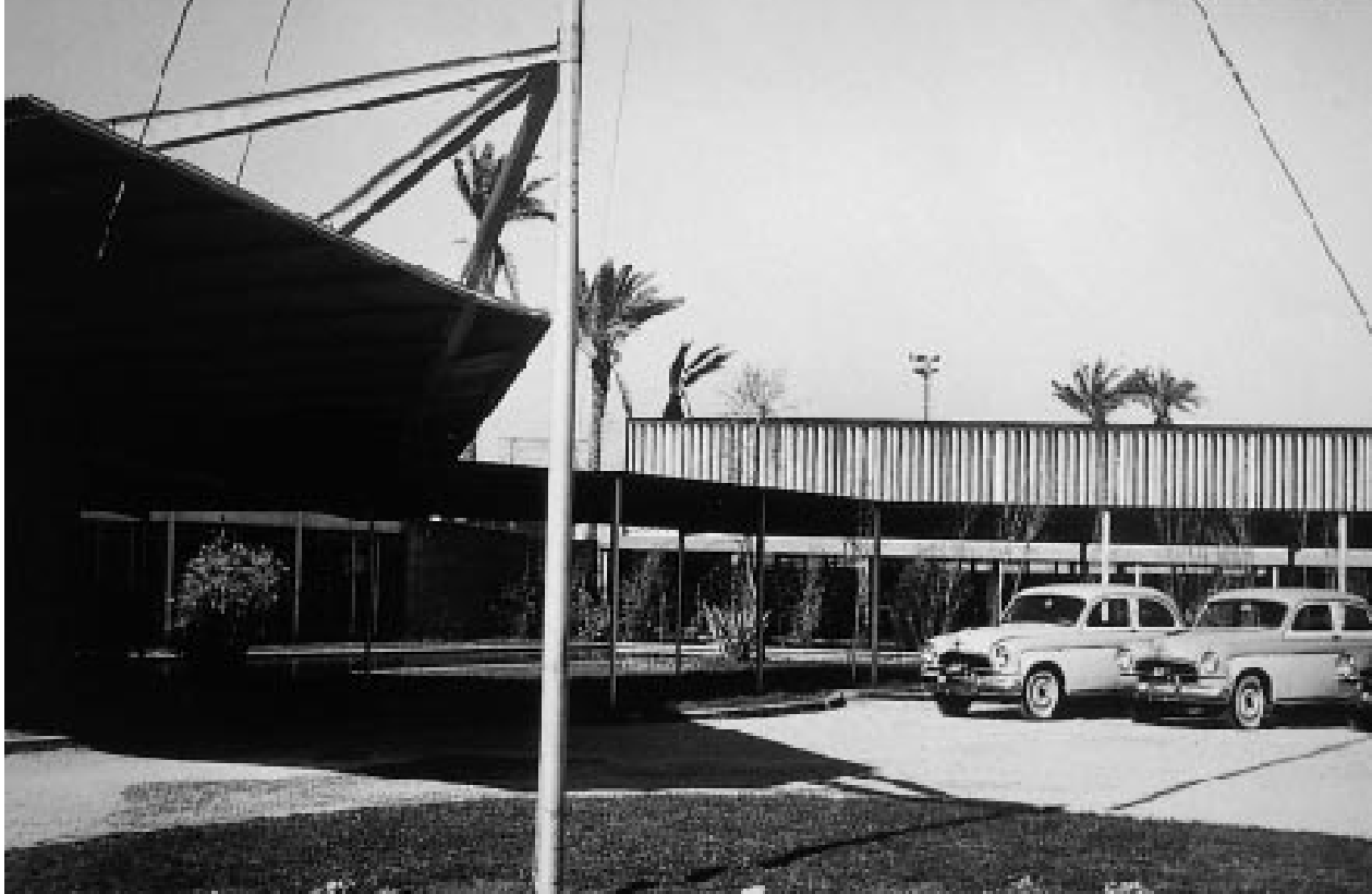
i08 Pérgola-corredor que enlaza los pabellones
