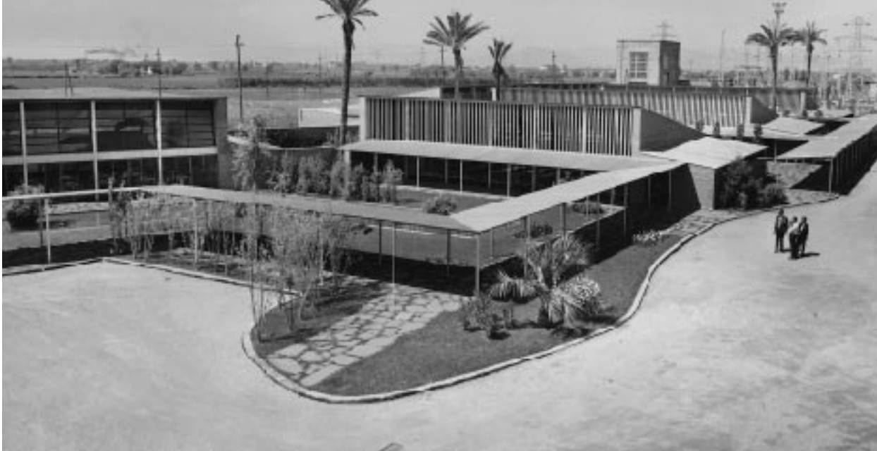
Vista general de los comedores i 04
