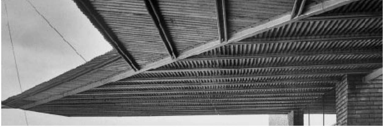
i25 Marquesina de entrada de los comedores
