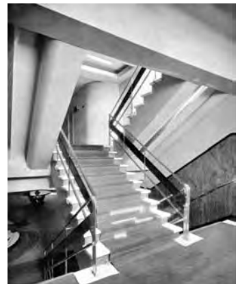
Fig. 3. Barandilla de tubos de níquel. Edificio Capitol.
