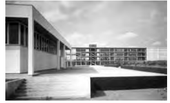
James Cubitt, Departamento de Ingeniería, Kumasi, Ghana.
