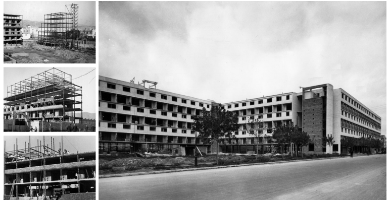
Fig. 5. José Luis Sert, Josep Torres Clavé, Juan Bautista Subirana, Casa Bloc, 1933-1934. Secuencia de la construcción por fases de ejecución de industriales, en Sert Collection, Frances Loeb Library - Harvard Graduate School of Design, GSD.
