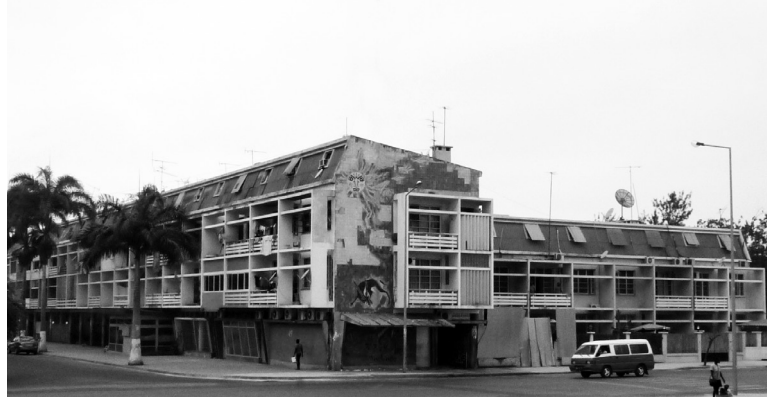
Fig. 4. Bloque Sol, Lobito, Arquitecto Francisco Castro Rodrigues, 1963-1965 (foto: © IL, 2010).
