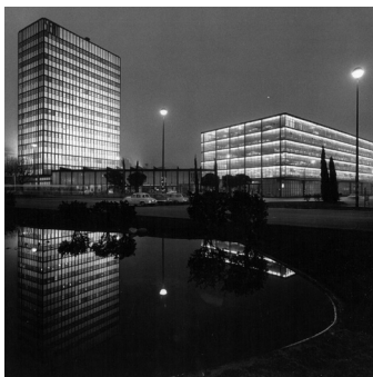
Fig. 3. Imagen nocturna de los edificios de la Filial Barcelona de la S.E.A.T. de C. Ortiz-Echagüe y R. Echaide. Fotografía de F. Catalá-Roca (1966).
