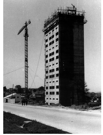
Fig. 6. Vista de un Bloque en Construcción. Archivo J. Basilio Bas.
