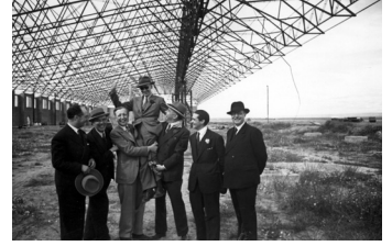
Fig. 12. Hangar de Torrejón de Ardoz .
