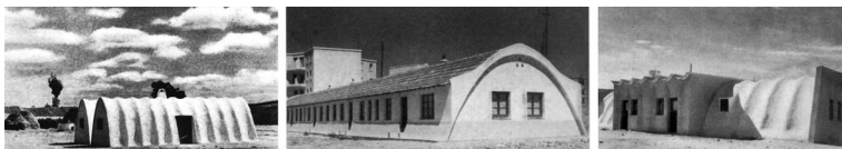
Fig. 5. Proyecto de Rafael de la Hoz en Palma del Río (Córdoba, 1953) y propuestas de Delgado Lejal y Cavestany. Fuente: FERNÁNDEZ-ISLA, J.M., La vivienda experimental. Concurso de viviendas experimentales de 1956 , Fundación Cultural COAM, Madrid, 1997.
