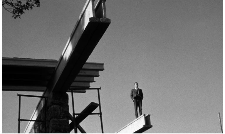
Fig. 2. Vigas PACADAR en una de las primeras viviendas de Fernando Higuera. Archivo Fundación Fernando Higuera.
