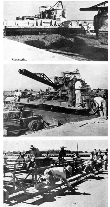
Fig. 6. Construcción de un aeropuerto en Rota. Informes de la construcción , n. 85, 1956.
