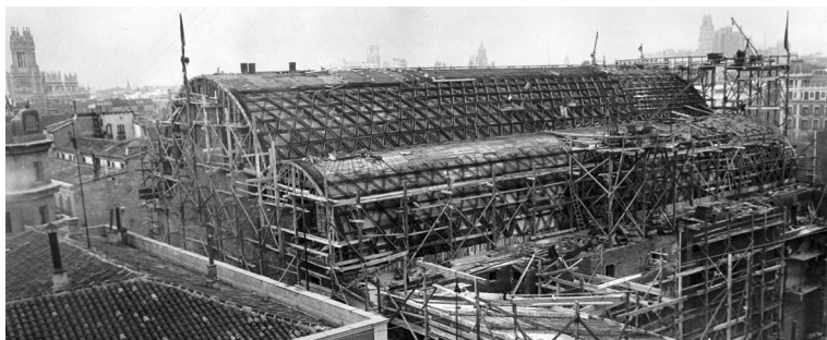
Fig. 11. Frontón Recoletos durante su construcción.
