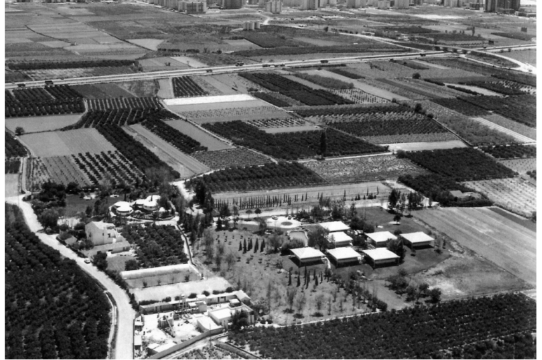
Fig. 1. Casa familiar de Julio Bellot (centro de la imagen a la izquierda), junto a las instalaciones del Estudio Profesional de GO.DB (derecha), y laboratorio de investigaciones (abajo, en construcción).
