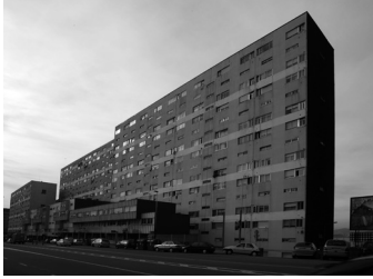
Fig. 7. Travesía de Vigo, Vista actual del edificio. Alba Vázquez Carpentier.
