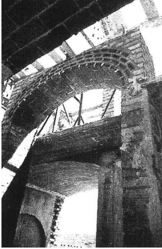
Fig. 1. Fotografía del proceso constructivo de las casas abovedadas de en el barrio de Usera de Madrid. Revista Nacional de Arquitectura , n. 14, p. 55.
