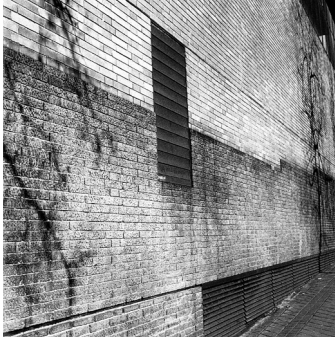
Fig. 6. Fachada del Gimnasio Maravillas (1961, Madrid). Alejandro de la Sota.
