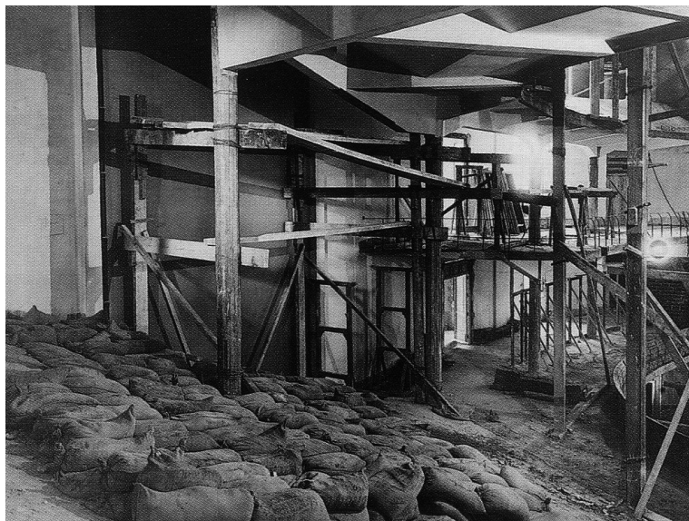
Fig. 3. Monumental Cinema, pruebas de carga de la estructura en ANASAGASTI, T., "El edificio", en La Construcción Moderna , 1923, n. 21.
