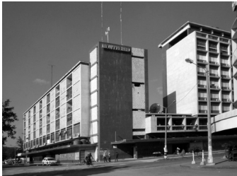
Fig. 2. Conjunto Monteiro&Giro , Quelimane, Arq. Arménio Losa, 1956-1961 (foto: © IL, 2010).
