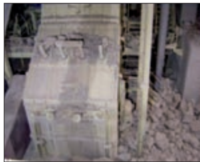
Incidente debido a un atasco en la chimenea. La fórmula de R. Kvapil de 1965 está desfasada.
