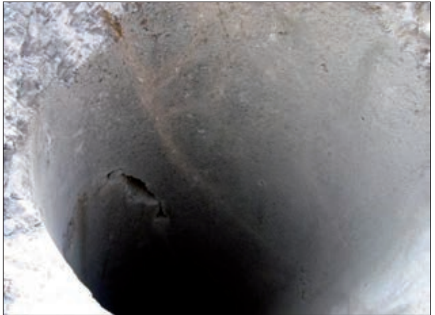
La chimenea parece “pulida” con el Raise Boring.
