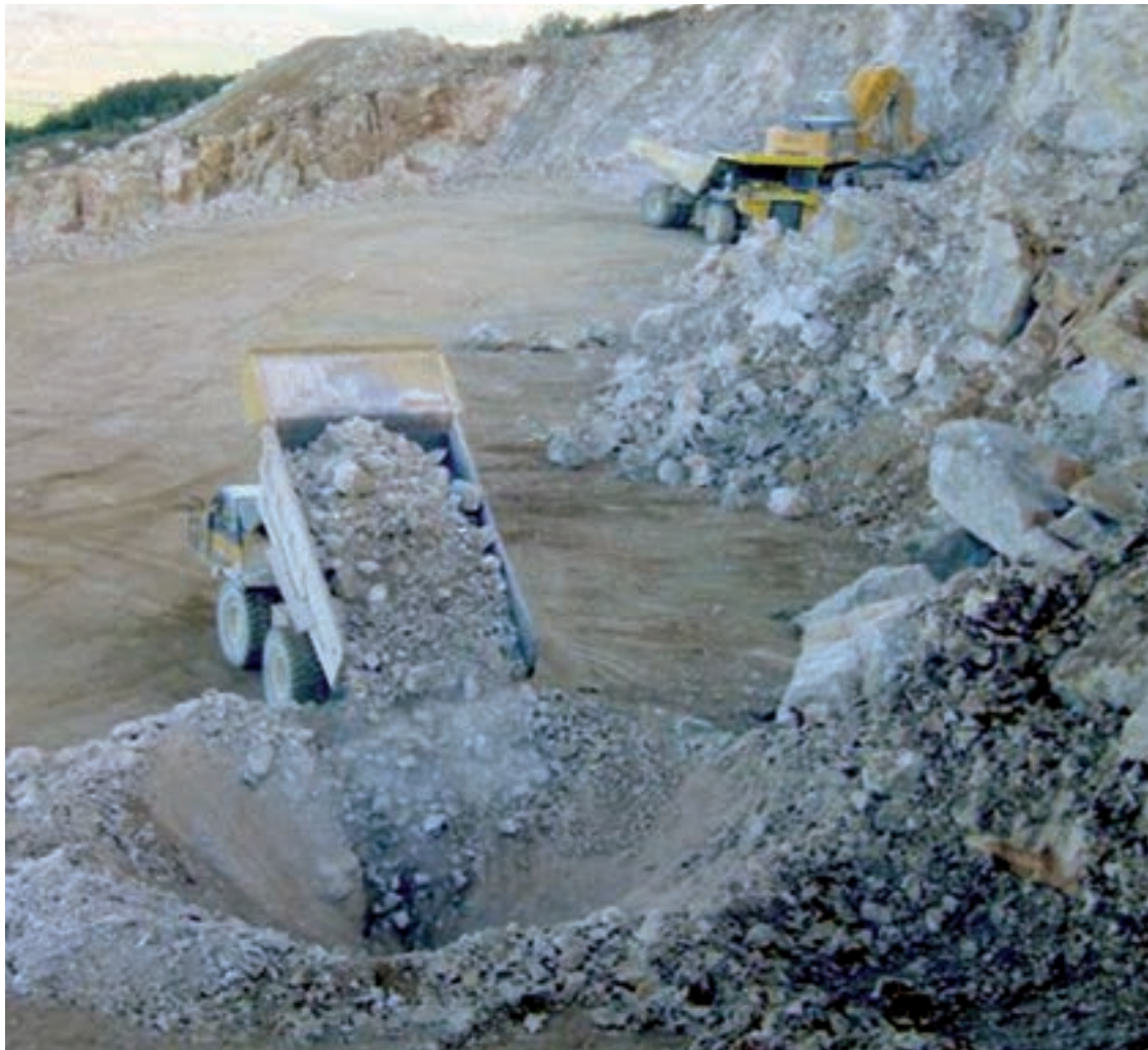
Explotación por chimenea - galería en Canteras de Alaiz, S.A. Proyecto de Ejecución y Dirección de Obra de LKS
