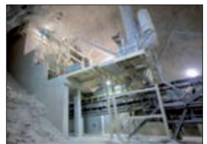
Planta de tratamiento primario 1.600 t/h. Cantera de La Nueva.
