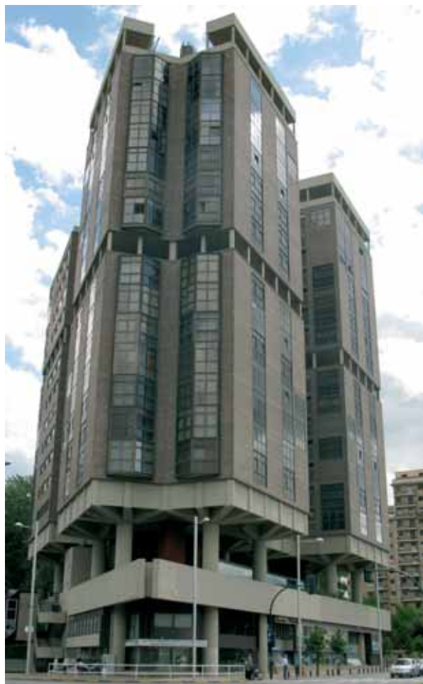
Edificio Singular de Pamplona.
