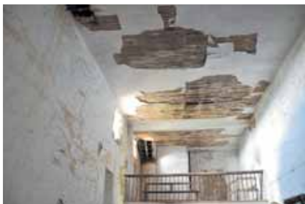
Las cubiertas de la iglesia de Usechi.
