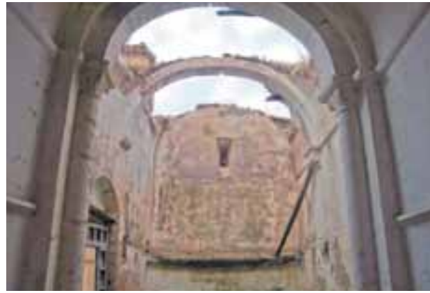
La iglesia de Montalbán, sin su bóveda.
