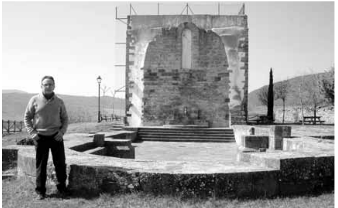
Pedro Javier Sola Rodrigo, concejal de Cultura de Leache, junto a la planta de la antigua iglesia, que fue rehabilitada. Al fondo, la única pared que quedó en pie, y que se ha empleado como frontón.
