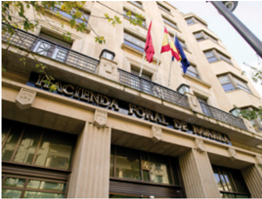
Edificio de la Hacienda Foral de Navarra en la calle Carlos III de Pamplona.
