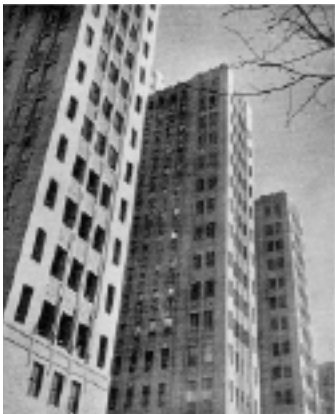
Fig. 2. Vista parcial de los martillos de enfermería del Medical Center de Nueva York. Se pueden ver en los frentes los solarium. En algunos todavía no se ha instalado el cerramiento de cristal de cuarzo. Publicada por Sánchez Arcas en su artículo de Arquitectura de abril de 1929.
