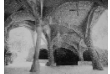
Fig. 6. Superficies regladas construidas por Gaudí según el sistema tabicado, en la cripta de la Colonia Güell.
