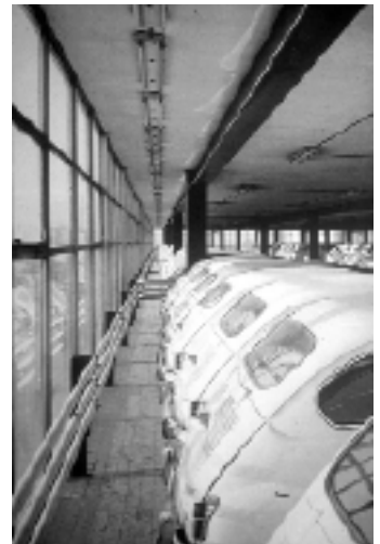
Fig. 12. Interior del Depósito de automóviles, 1959.
