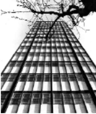
Fig. 22. Torre de Oficinas. Filial SEAT, 1964.
