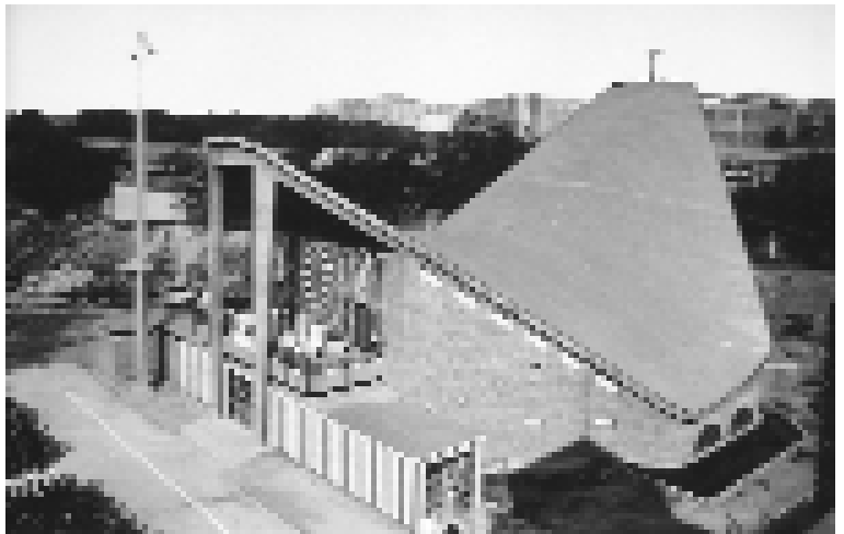
Fig. 14. Bóveda tabicada en forma de paraboloides hiperbólico de la Iglesia del Niño Jesús, 1964.
