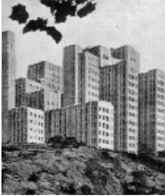
Fig. 1. Vista del Medical Center de Nueva York. Publicada por Sánchez Arcas en su artículo de Arquitectura de abril de 1929.
