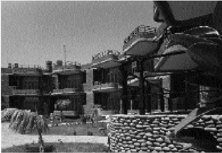
Apartamentos Don Pedro. Zona interior. Detalle del hormigón recubierto por callaos de playa.
