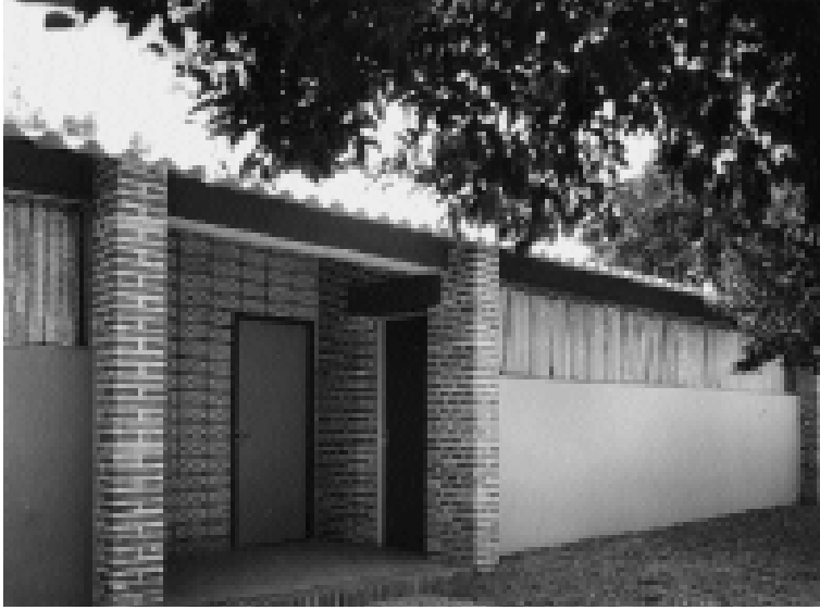
Exterior de microescuela con vivienda de ambiente único.
