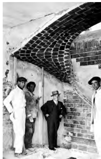
Fig. 7. Sigfried Giedion. Fernando García Mercadal durante las obras de la Colonia Residencia en Madrid. Abril 1932. gta Archiv, legado Giedion.
