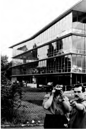
Fig. 2. Edificio destinado a garaje, Colonia, Alemania, 1958.
