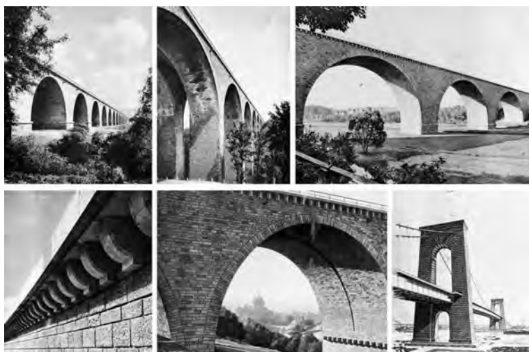
Fig. 1. Puentes expuestos en la “ Neue Deutsche Baukunst / Nueva Arquitectura Alemana ”, reproducidos en el catálogo y en la conferencia de 1943 pronunciada por Paul Bonatz, autor de algunos de ellos. SPEER, Albert, Neue Deutsche Baukunst. Nueva Arquitectura Alemana , Volk und Reich Verlag, Berlín, 1941.
