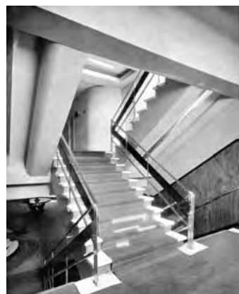
Fig. 3. Barandilla de tubos de níquel. Edificio Capitol.
