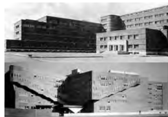
Fig. 8. Volumetría escalonada. Arriba: Facultades de Físicas y Químicas. Abajo: Baker Dormitory.
