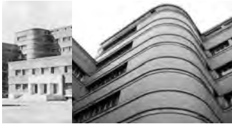
Fig. 3. Facultad de Químicas. Izquierda: Escalera y Aula Magna. Derecha: Detalle de la escalera.
