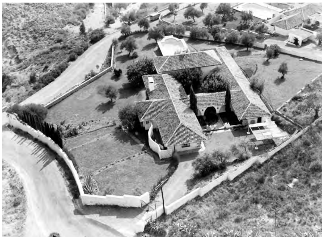
Fig. 6. Vivienda unifamiliar en Rancho Domingo (de R. Mosher).
