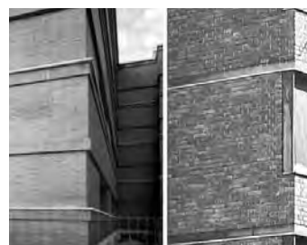
Fig. 4. Izda. Detalle de los huecos y del aparejo del ladrillo a soga y tizón. Izquierda: Facultad de Químicas. Centro: Escuela Politécnica de Otaniemi. Derecha: Baker Dormitory .
