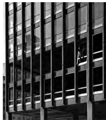
Fig. 8. Detalle de la fachada de los apartamentos Lake Shore Drive en construcción.
