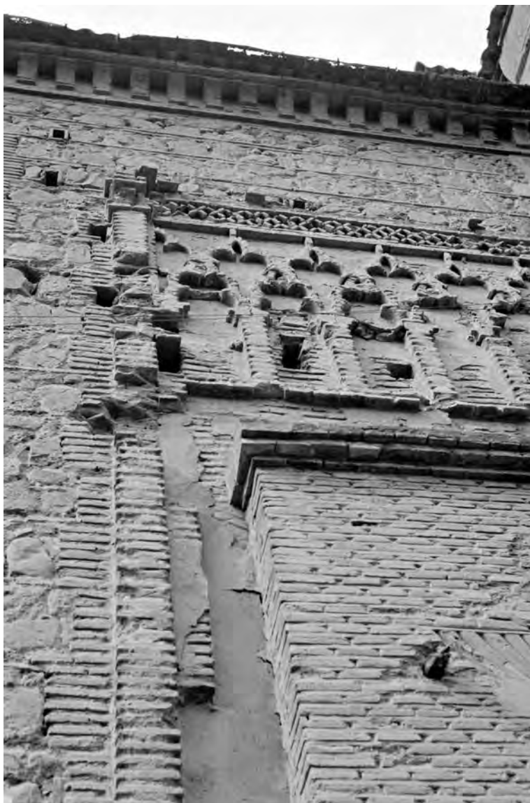
Fig. 6. Sigfried Giedion. Detalles de muros de Toledo. Abril 1932. gta Archiv, legado Giedion.
