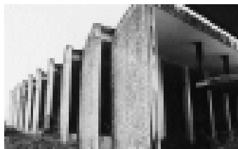
Iglesia. Detalle de los muros laterales.
