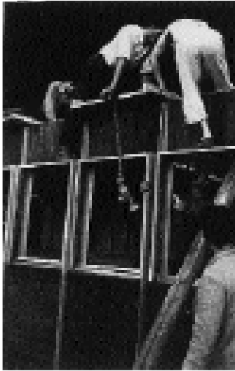
Jean Prouve. Vivienda prefabricada de Nancy. Paneles prefabricados.
