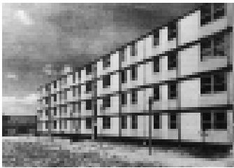
Concurso Viviendas Experimentales 1956. Fachada propuesta por Romay y Sánchez Lozano; cercos prefabricados de hormigón armado, revestimiento de placas de fibrocemento.
