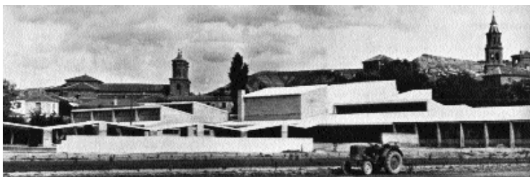
Instituto Laboral en Alfaro. Vista exterior de aulas y rampa. José Antonio Corrales.
