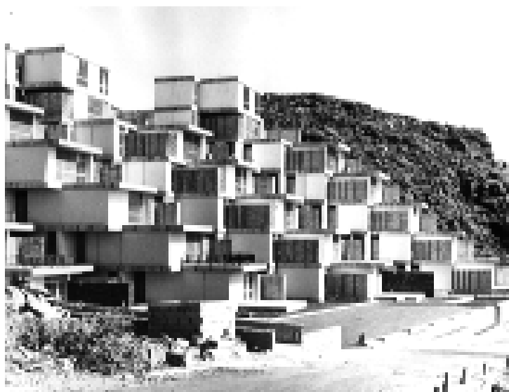
Vista del conjunto durante las obras.
