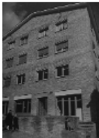
4. A. De Moragas, Edificio residencial de la calle Gomis, Barcelona 1953-1954
