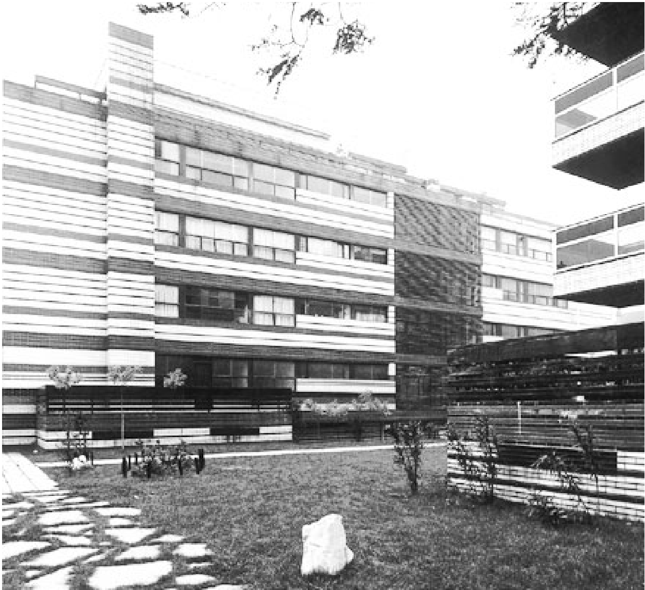
Vista de la fachada interior del bloque de la calle Lejona 125
