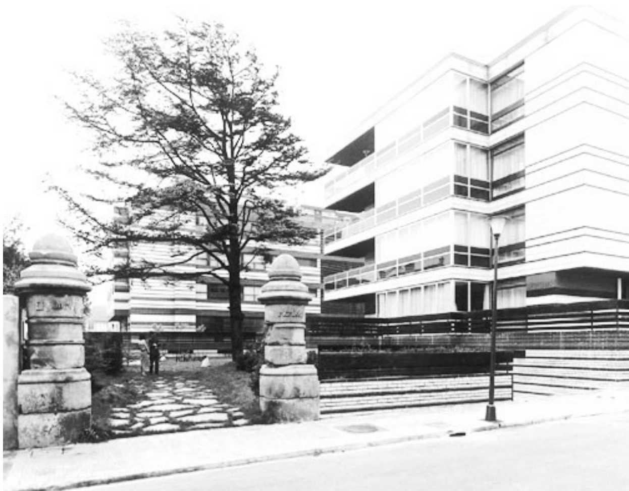
128 Vista desde la entrada del garaje de la calle Los Tilos
