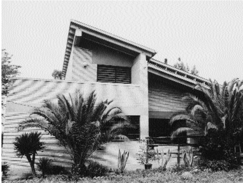
Fig. 27. Casa familiar, Fundación mi casa. HH. Dominicas, Garrapinillos, Zaragoza. Arquitecto: José Romero y grupo Z.
