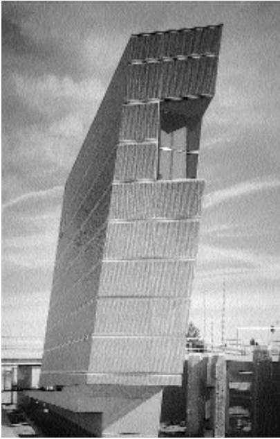
Fig. 14. Puente y puesto de control. Purmened. 1998. Van Berkel.
