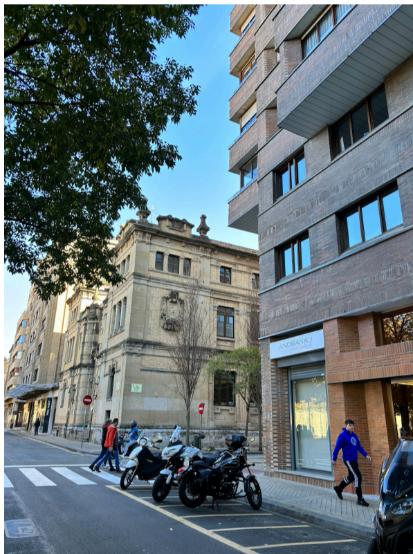
El edificio de Correos (izquierda) y el bloque que sustituye a la casa de baños (derecha).Foto de: Guillermo Ferro Maynar
