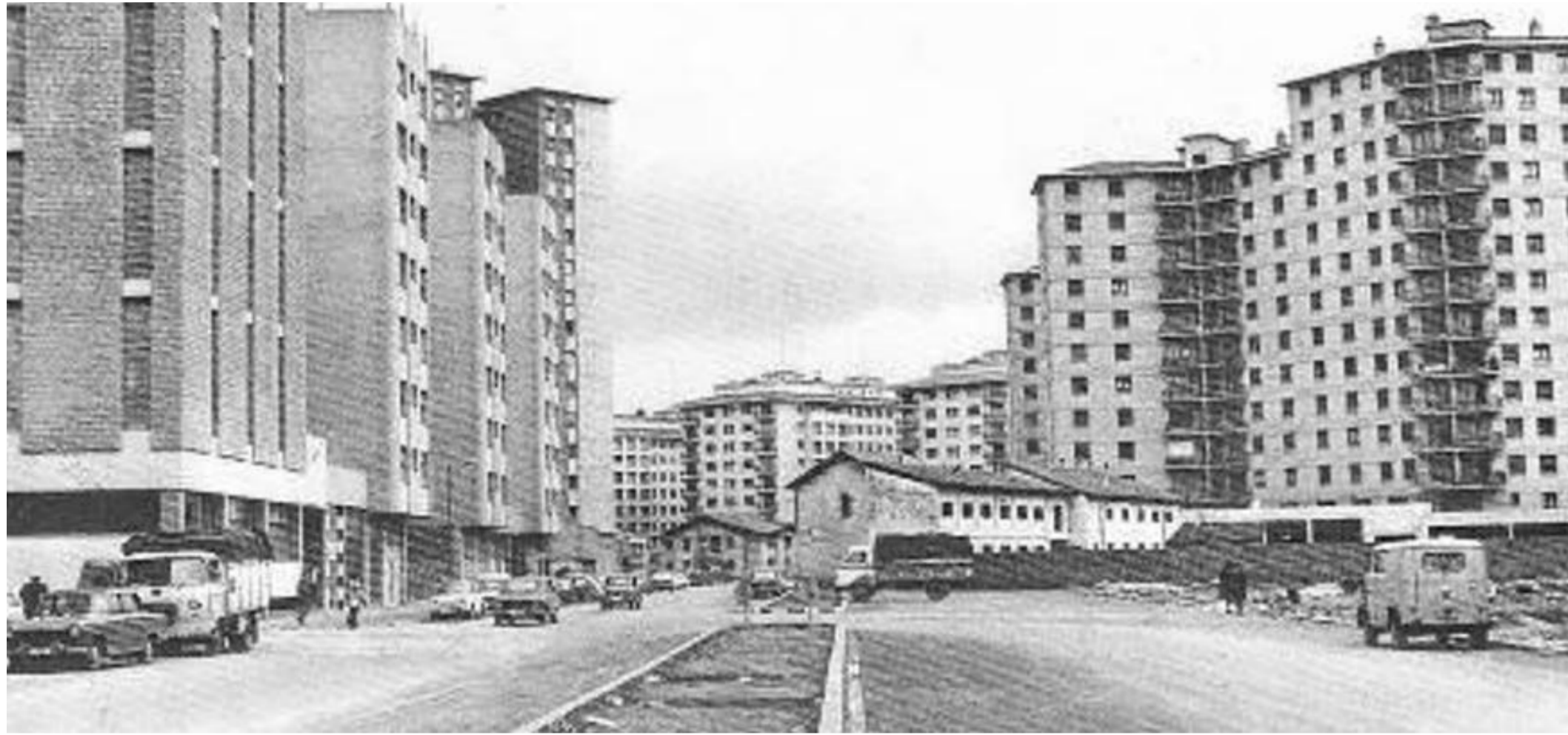
1972. La Avenida Bayona meses antes a su inauguración.
