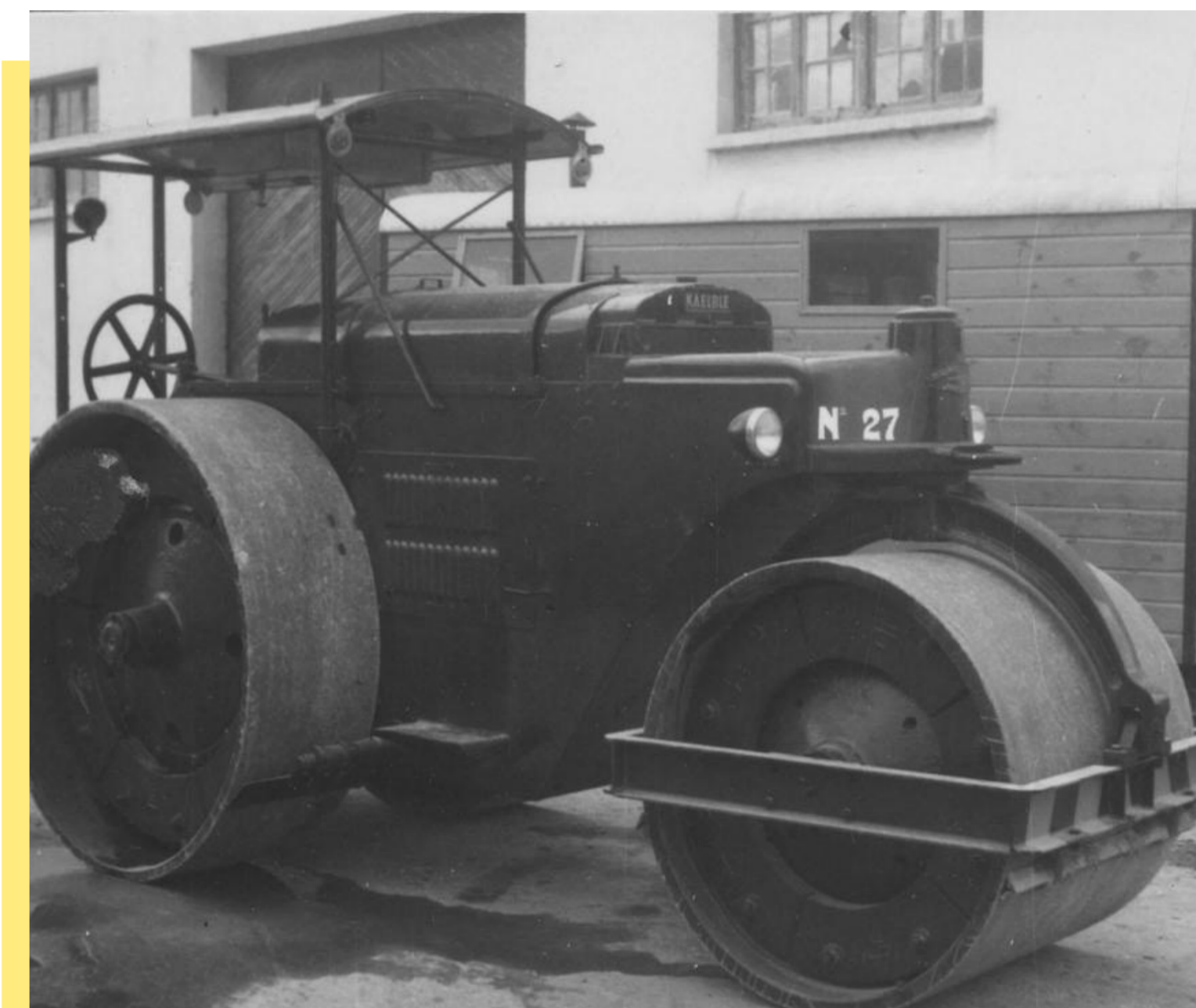
Apisonadora de 1957 fabricada por Metalúrgica de San Martín S.A. con licencia Kaelble y propiedad de la Dirección de Caminos de la Diputación Foral
