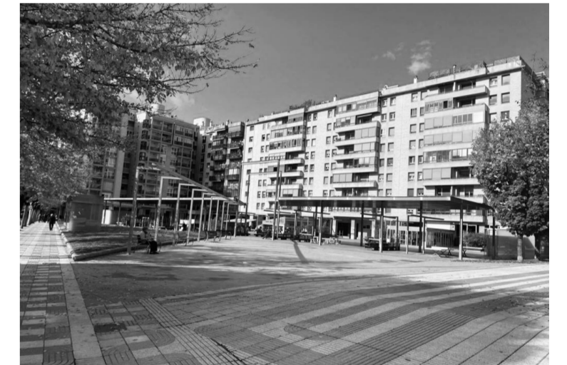
Plaza Azuelo: Esta plaza terminó de construirse a mediados de 1978 y fue realizada por el promotor navarro Félix Andía Larraya. Destaca la zona que reproduce un anfiteatro clásico. Pero en torno al año 2000 tuvieron que tirar todo y se hizo como se conoce hoy a la plaza de Azuelo.
