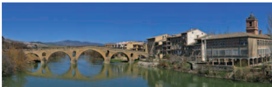
Figura 27. Vista de Puente la Reina, una vez restauradas sus calles.
