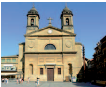
Figura 14. San Juan de Estella (Navarra). Colapsos de suelo por obras adyacentes.
