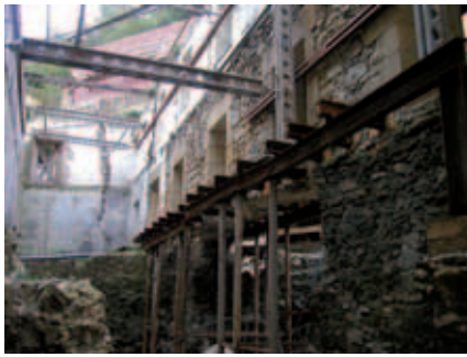
Figura 19. Recalce de una iglesia con micropilotes.
